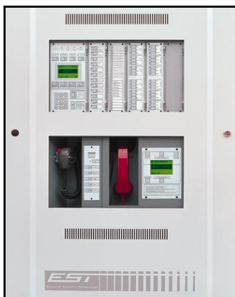
แผงควบคุมระบบแจ้งเหตุเพลิงไหม้
